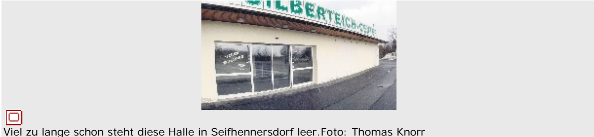
Viel zu lange schon steht diese Halle in Seifhennersdorf leer. Foto: Thomas Knorr
